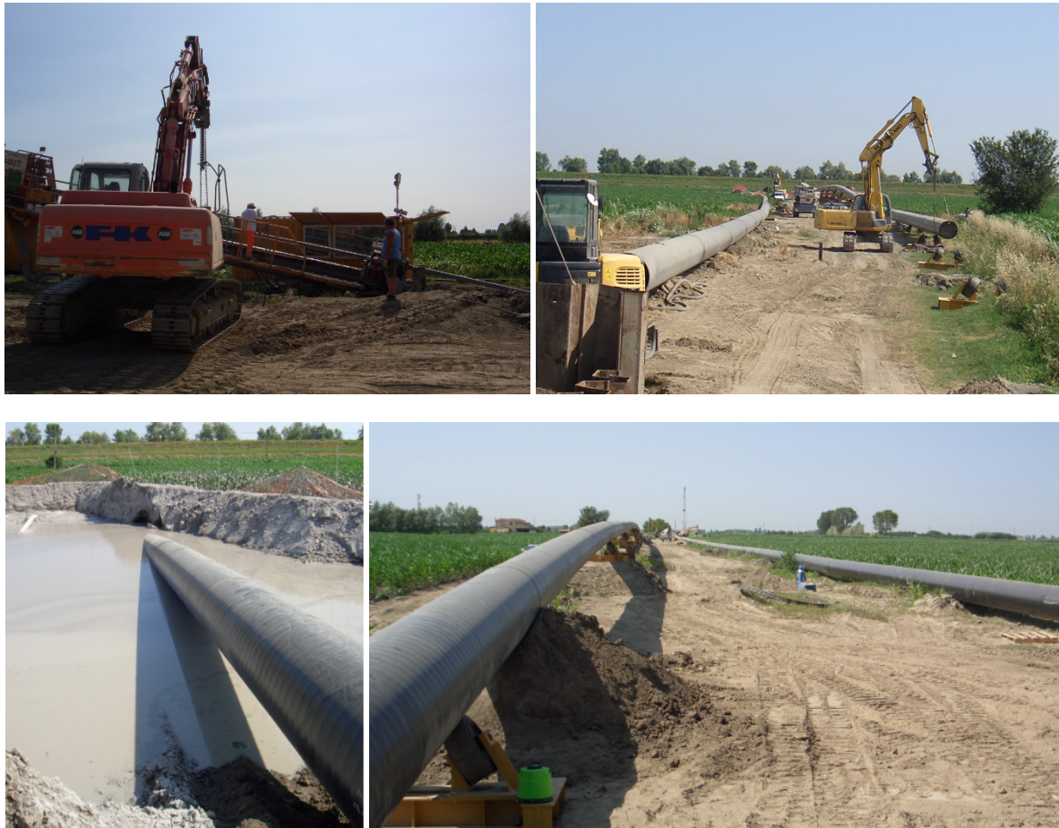
Figura 4: Fasi di realizzazione di una T.O.C.
