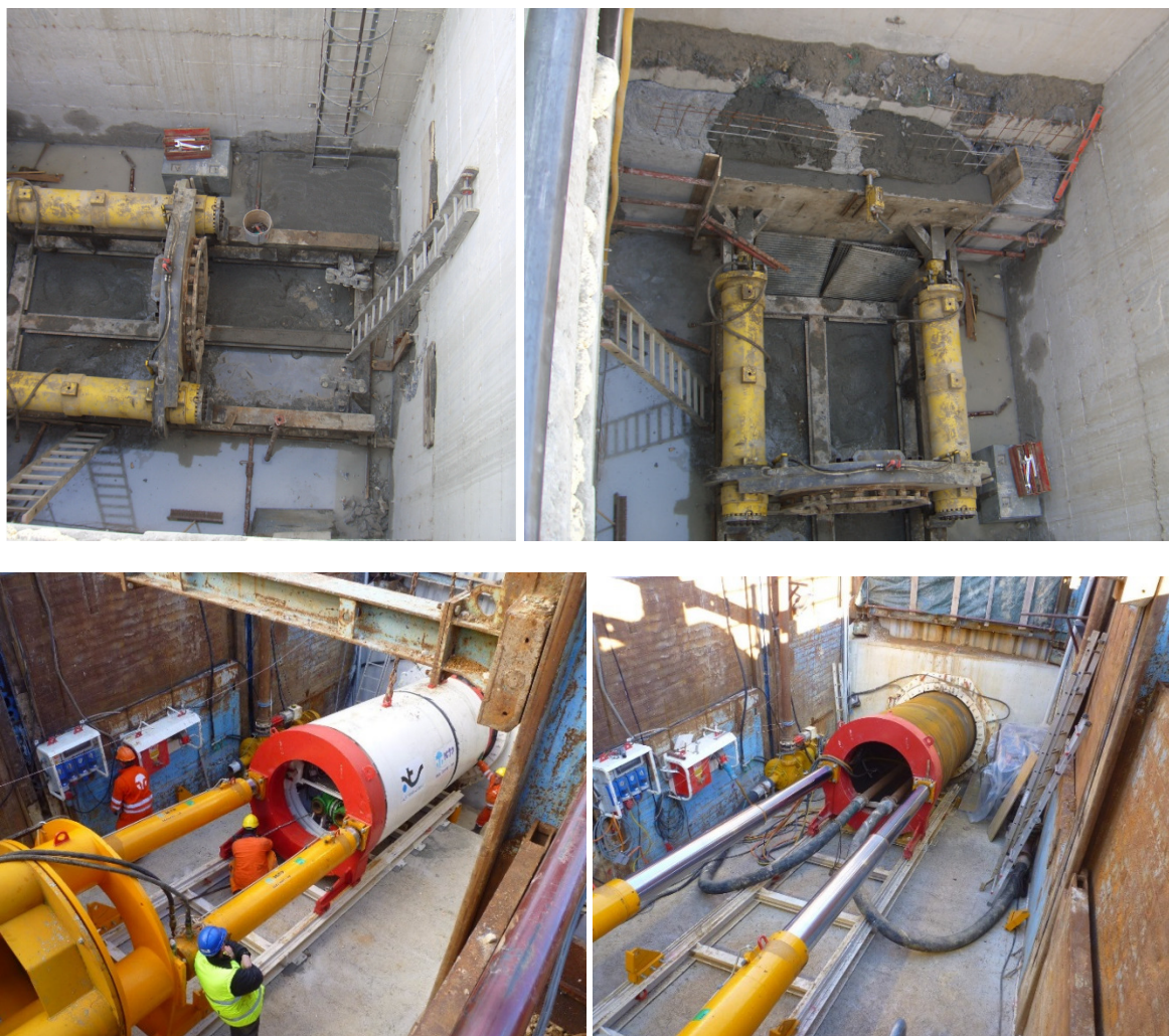
Figura 5: Esempio di pozzo di spinta per tubazione DE 1490 in PRFV a 8 m di profondità e tubazione in acciaio DN 1800 mm.
