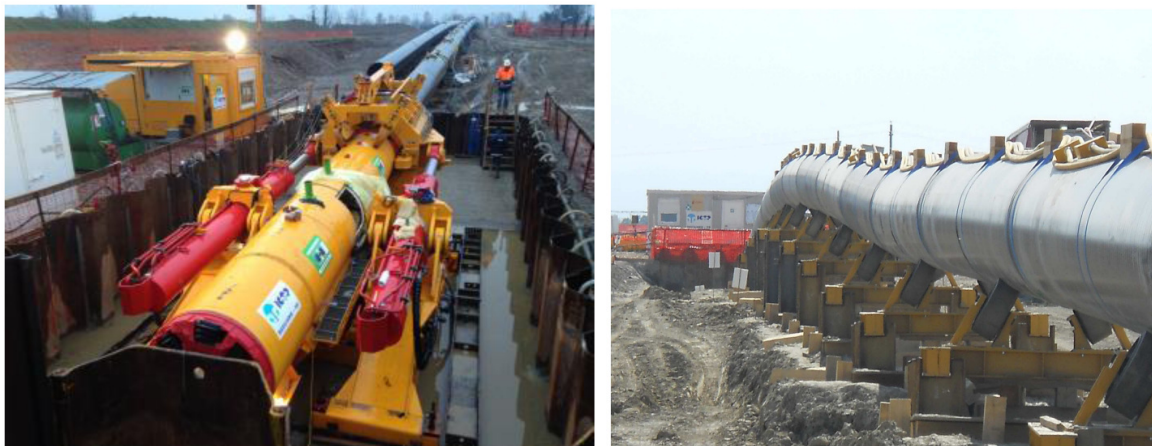
Figura 7: Esempio di attraversamento realizzato con tecnologia del Direct Pipe.
